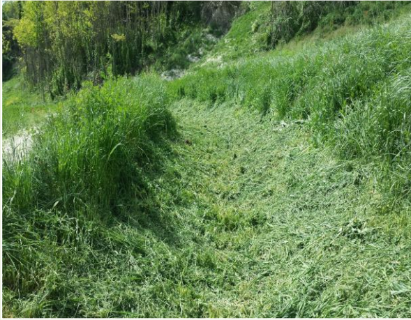
Spece erbacee allettanti che foderano le canalette in terra ed evitano l'erosione
