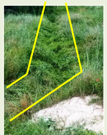
Spece erbacee allettanti che foderano le canalette in terra ed evitano l'erosione
