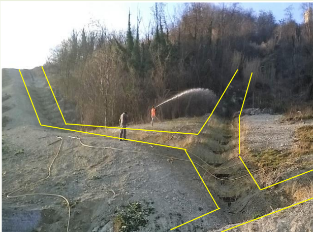
Spece erbacee allettanti che foderano le canalette in terra ed evitano l'erosione
